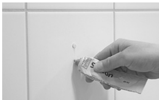
[ Bild 4.] VIKTIGT! Våtrumssilikon i pluggen och runt hålet.
