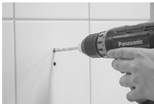
[ Bild 2.] 7 mm borrar endast genom kakel (använd kakelbollar) Våtrumssilikon i hålet.
