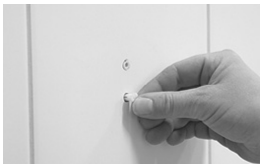
[ Bild 3.] Montera plastplugg avsedd för 5.5mm hål.
